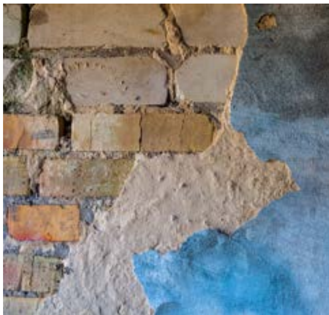
Afgebrokkeld stucwerk
